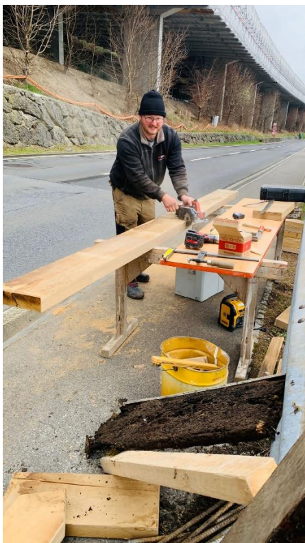
Zuschneiden, man beachte den morschen alten gefährlichen
