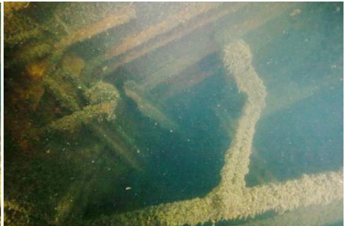
Laderaum mit Blechwänden
