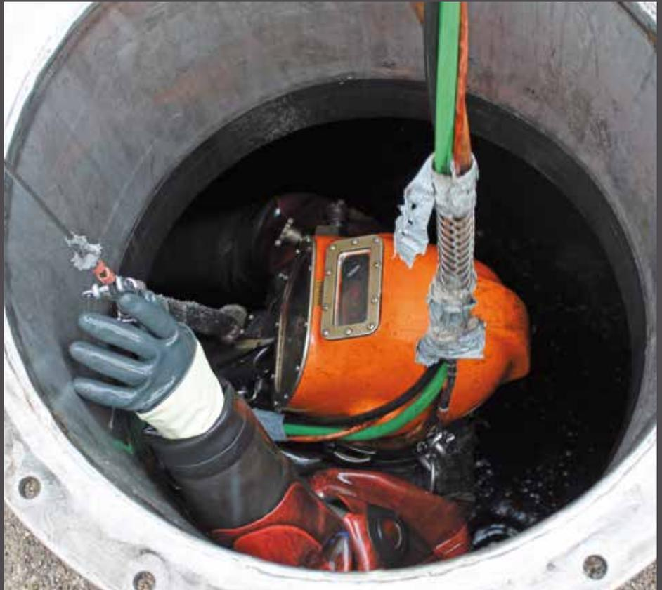
Die fünf Industrietaucher stehen voraussichtlich vier bis fünf Tage in Bazenheid im Einsatz. Bis dahin werden sie täglich rund 40 Kubikmeter Material ausräumen. Dieses wird über ein Rohleitungssystem direkt aus dem Faulturm auf eine Siebbandpresse gepumpt, dort entwässert und anschliessend dem ZAB zur Verbrennung zugeführt.
