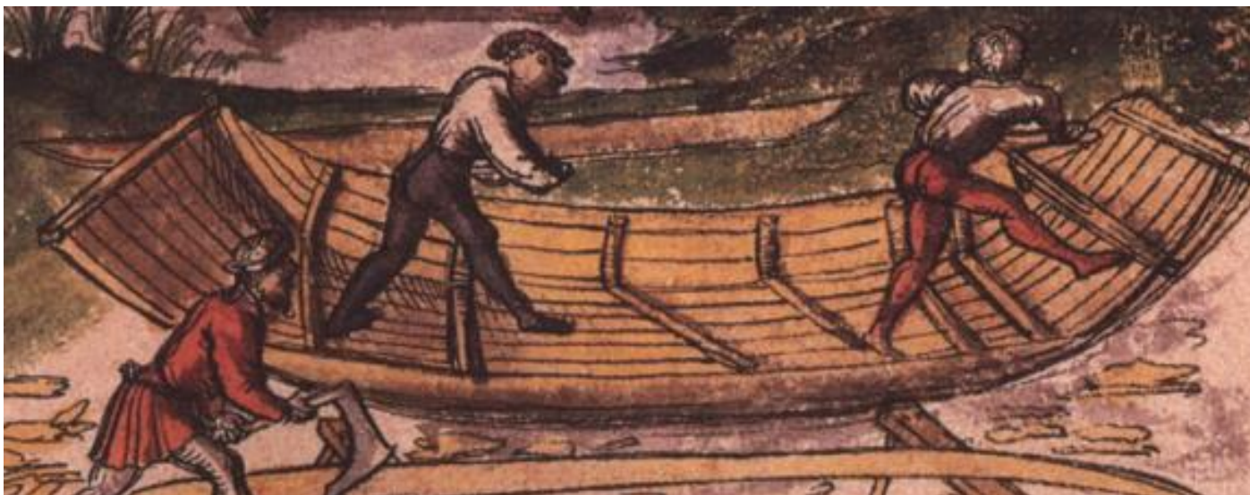
Schodoler Chronik: Schiffbau am Zürichsee im 16. Jahrhundert. Gut sind der flache Boden und die halbfertigen Seitenwände sowie der fortschreitende Einbau der aussteifenden Spanten erkennbar.
