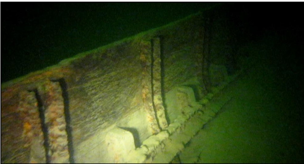
Diverse U-Profile aus Eisen wurden nachträglich eingebaut, um die Ladekapazität zu erhöhen
