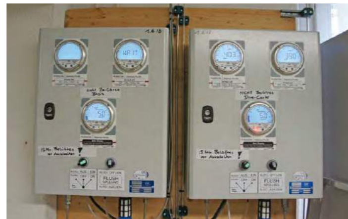
Für eine Basis, die wirtschaftlich denken muss, ist eine Gas-Überwachung meist zu teuer. Richard hat sich zwei davon gegönnt, mit denen er die Werte für CO, CO 2 und Öl prüfen kann. Auch vier zusätzliche Filter für die Luft sind im Einsatz.
