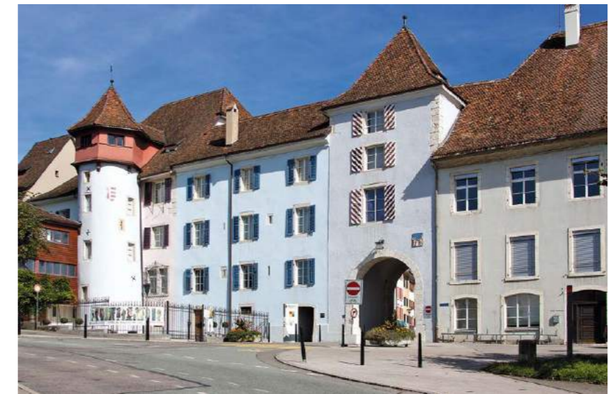
Porte de Porrentruy, Delémont, Roland Zumbueh
